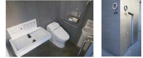
写真② B: おむつ交換トイレの内部と外観
