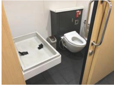
写真① おむつ交換台・着替え台が設置された個室
