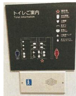
写真① トイレ入口の音声案内と触知案内図 (海の森水上競技場)
