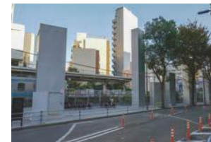
写真① トイレ外観
