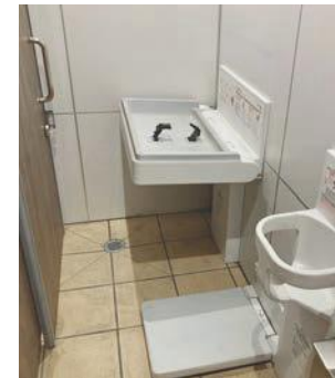
写真① おむつ交換台・着替え台が設置された個室
