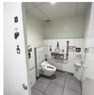
写真① おむつ交換台とベビーチェアが設置された個室
