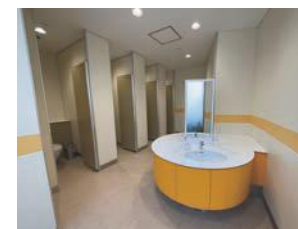
写真① 乾式の床、自動水栓
