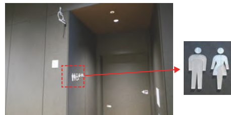
写真② トイレ入口と「男女共用」のピクトグラム
